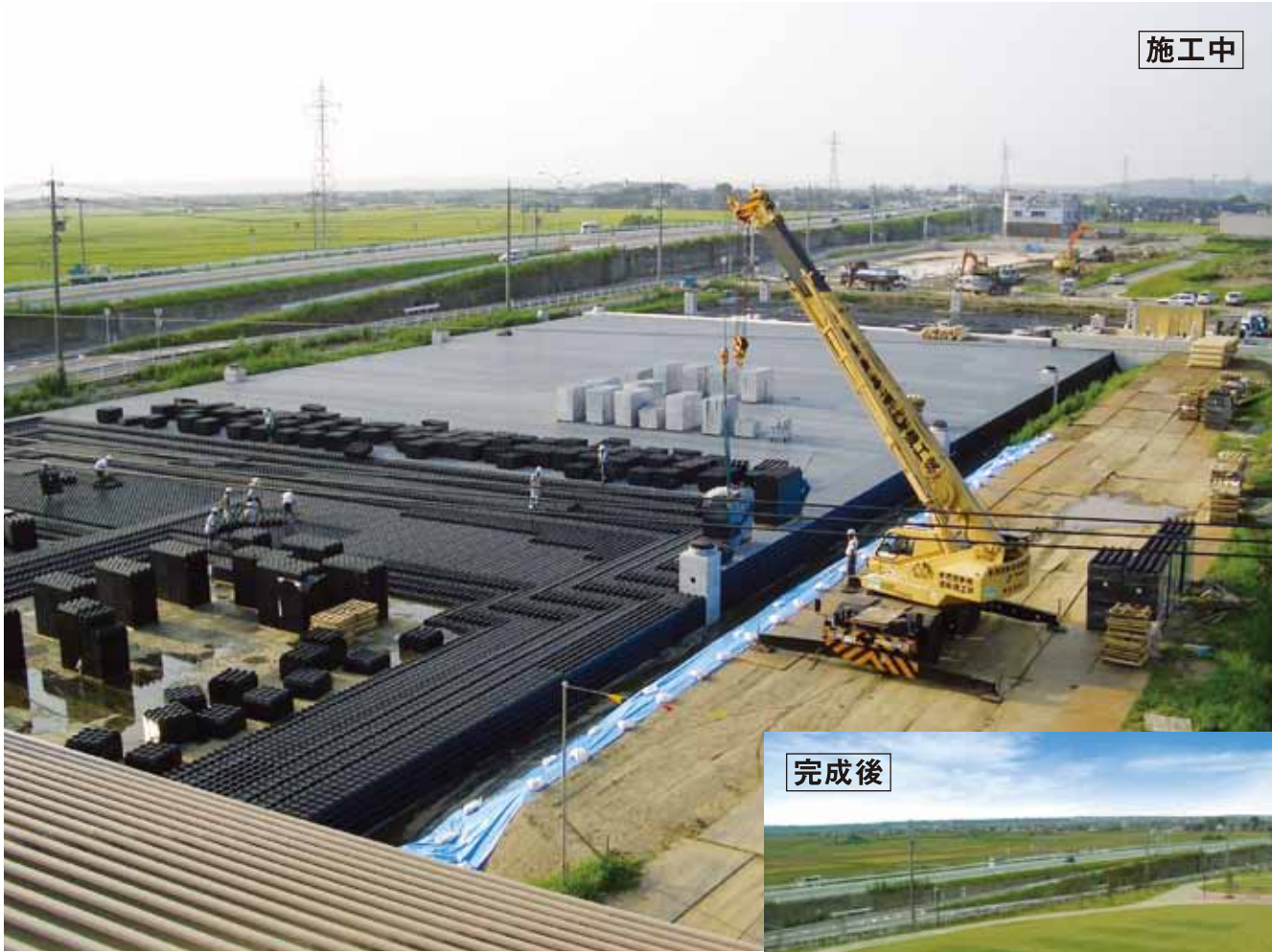
石川県内区画整理調整池 (貯水量: 9,200m³)
