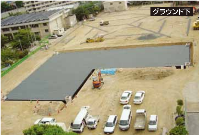
福岡県内小学校調整池 (貯水量: 800m³)
