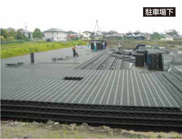
愛媛県内ショッピングセンター調整池 (貯水量: 6,600m³)
