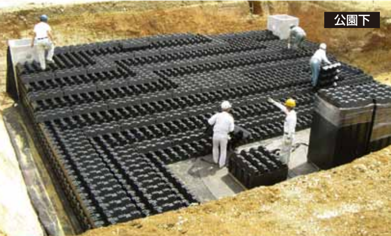
千葉県内宅地造成調整池 (貯水量: 420m³)
