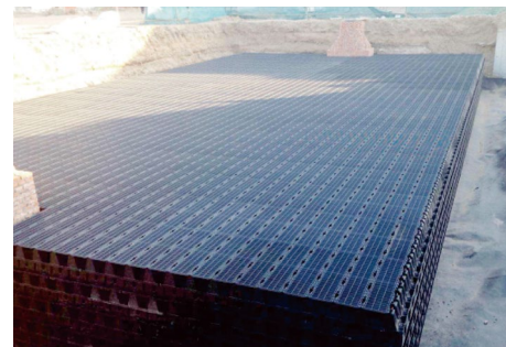
储水模块堆叠码放完成
