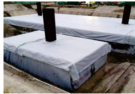
储水模块堆叠码放完成
