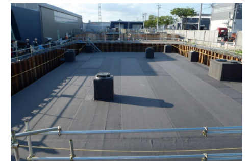
储水模块堆叠码放完成
