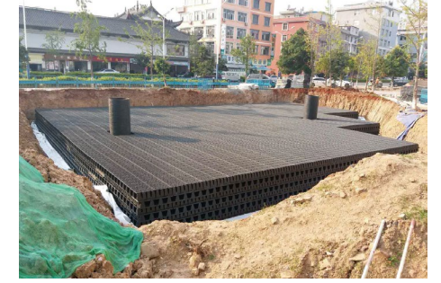
储水模块堆叠码放完成
