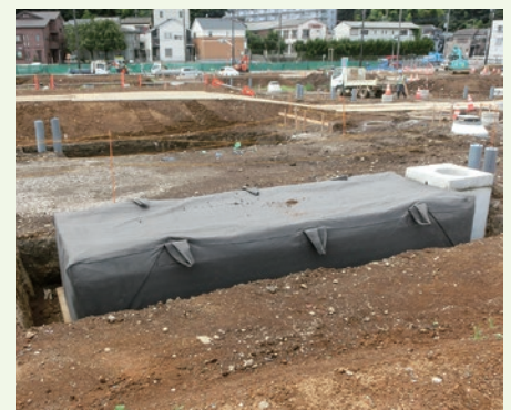
埼玉県内まちづくり造成 15m 3 ×140宅地
