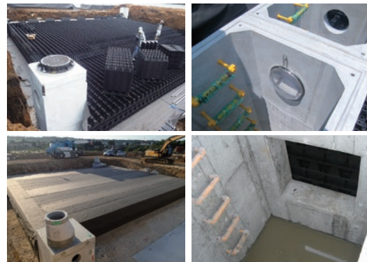
流入と流出柵を一体化した例 (大規模調整池)
