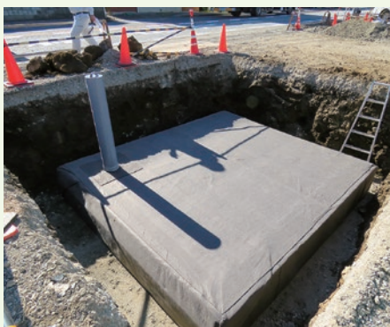
埼玉県内宅地造成 5m 3
