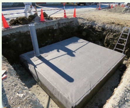
埼玉県内宅地造成 5m 3
