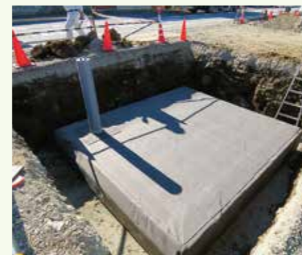
埼玉県内宅地造成 5m 3
